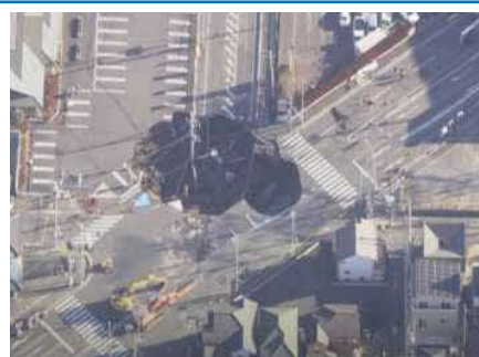
1月31日時点の 事故現場の状況
